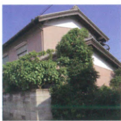
建物の確認 (破損・植栽の確認)
