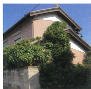
建物の確認 (破損・植栽の確認)
